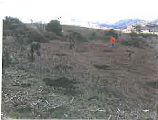
Foto 1. Limpieza y ahoyado manual de terrenos previa actuación.
